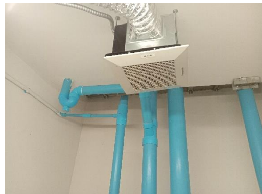
รูปที่ 24 พัดลมระบายอากาศในห้องพักรวมมูลฝอย
